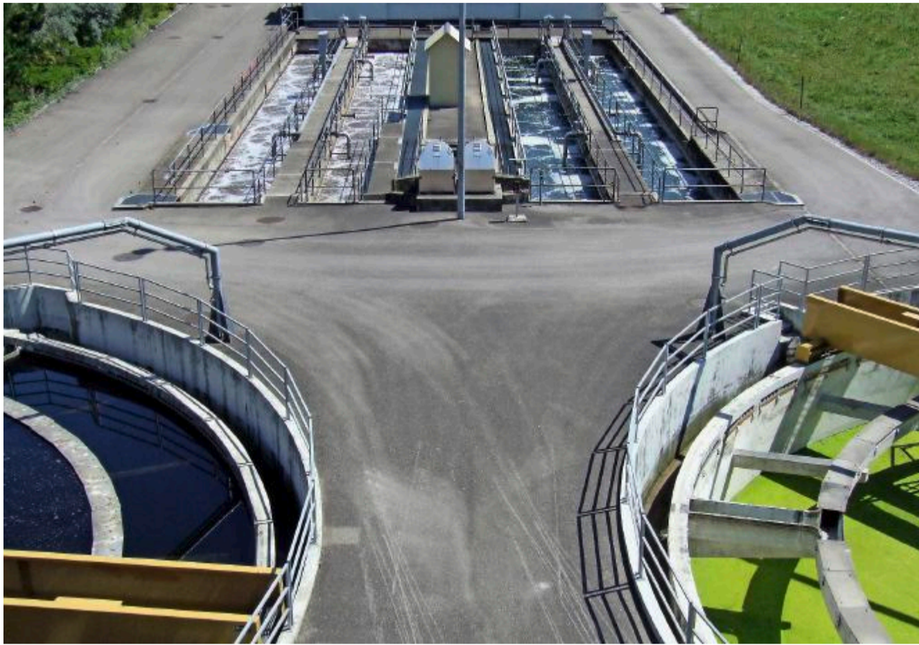
100 von 700 Schweizer Kläranlagen werden in den nächsten 20 Jahren umgerüstet: ARA Opfikon-Glattbrugg. Foto: Urs Keller (Ex-Press)
